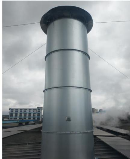
图 3.2 半钢 1000 万套硫化车间废气收集装置及废气处理装置及排气筒
