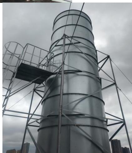
图 3.1 全钢 260 万套硫化车间废气收集装置及废气处理装置及排气筒
